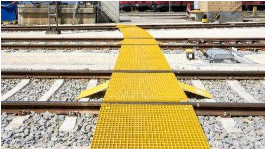
Abbildung 5-1: Beispielhafte Ausführung Gleisquerung mit Kupplungsaufaufblech
