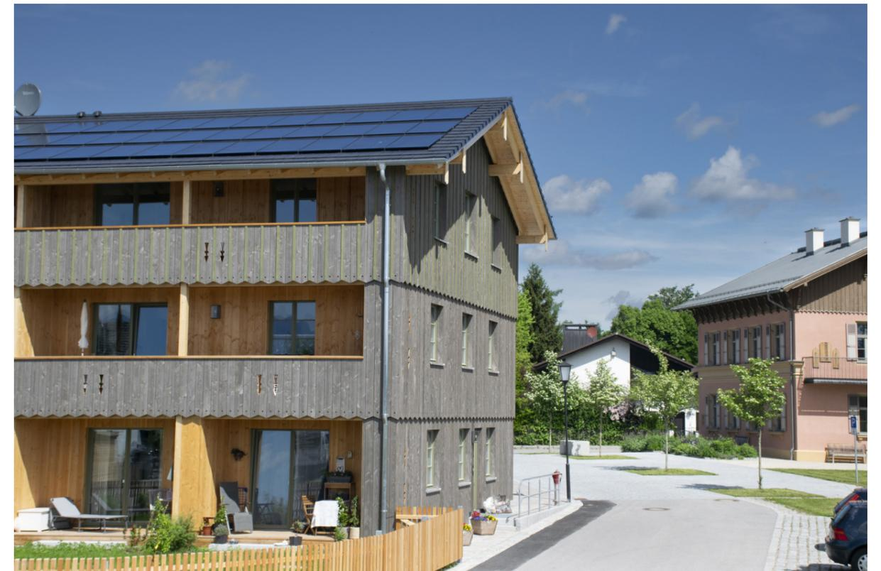
Die vorbildliche Ökobilanz ist insbesondere der Energieversorgung über eine Wärmepumpe geschuldet, welche über Erdsonden gespeist wird. Zusätzlich benötigter Strom wird über eine in die Dachfläche integrierte Photovoltaikanlage erzeugt. Die Fassade wurde mit vorverwittertem Holz verkleidet und passt sich durch filigrane Details und Ornamentik in zurückhaltender und dennoch moderner Weise der dörflichen Umgebung an.
