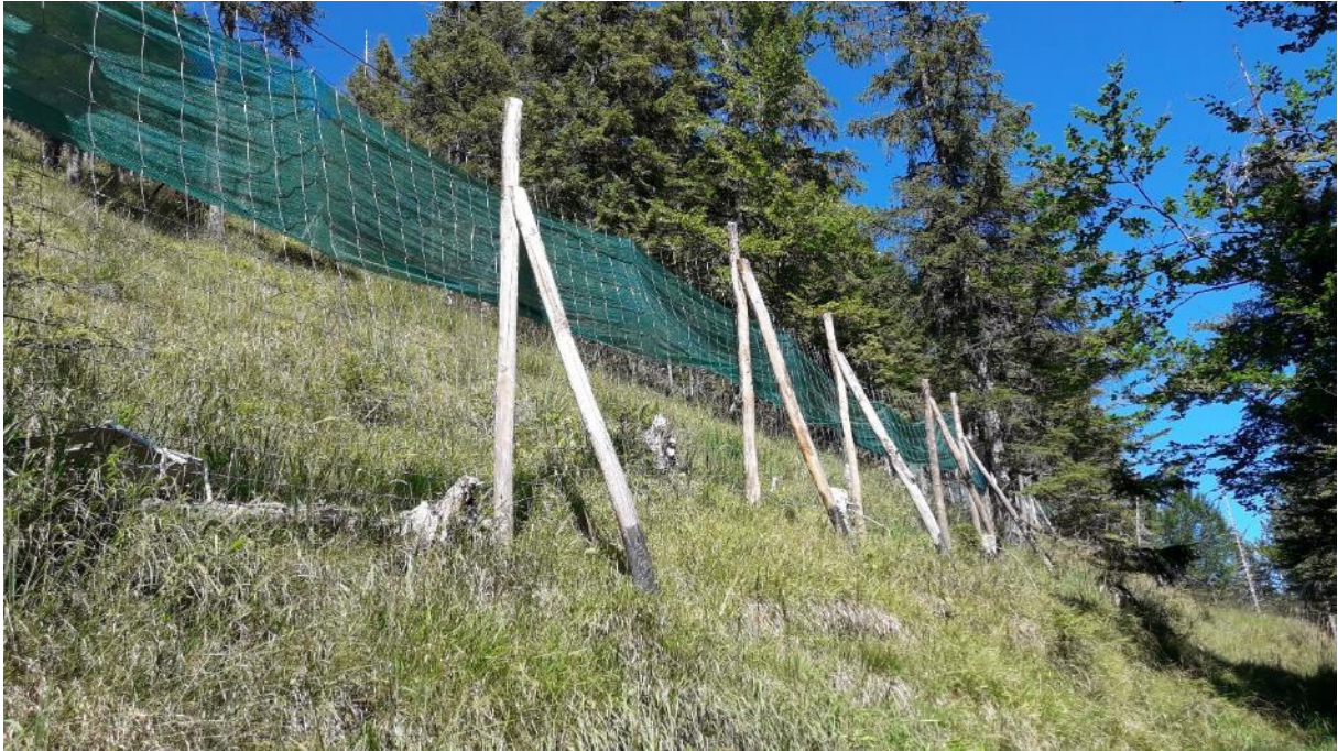
Abb. 48: Zum Schutz von Rauhfußhühnern teilweise verblendeter Forstschutzzaun (Foto: J. Buhl, AELF Ebersberg-Erding)
