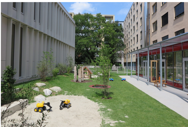
Freibereich der Krippe
